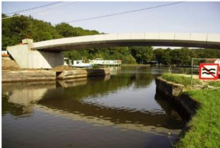
Figure 9 : exemple de pont à structure de poutrelles enrobées (pièce 2, p.43)
